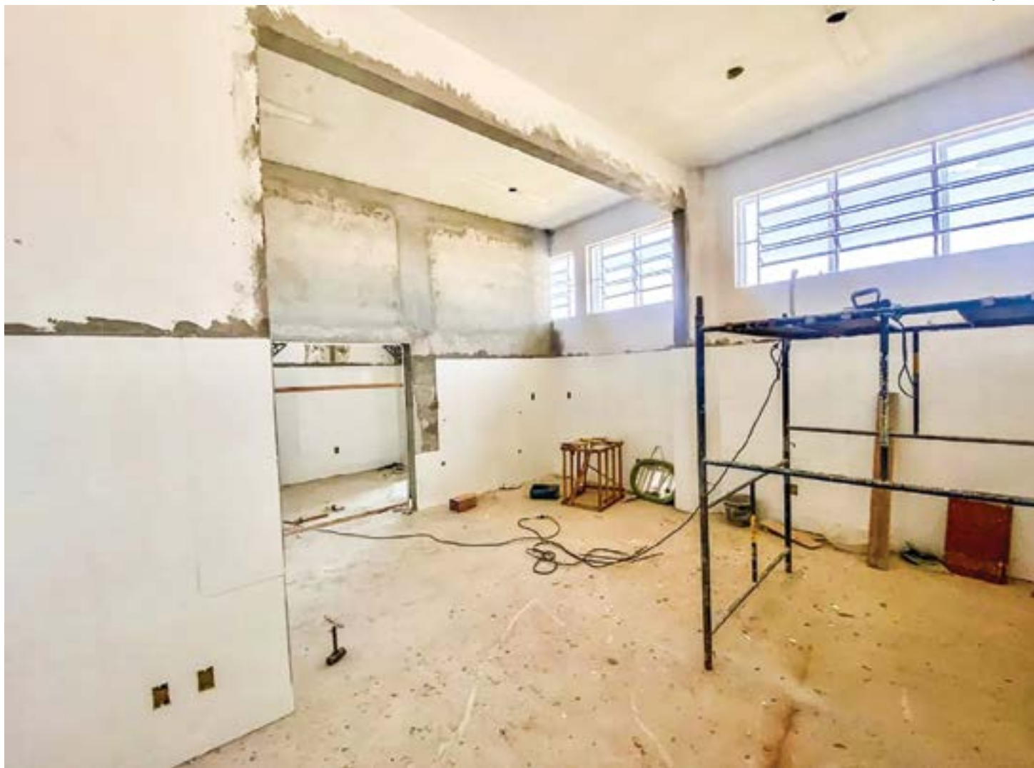
Obra da Cozinha Piloto de Cruzeiro, que entrou na fase de acabamento; projeção é que espaço deve atender cerca de sete mil alunos
