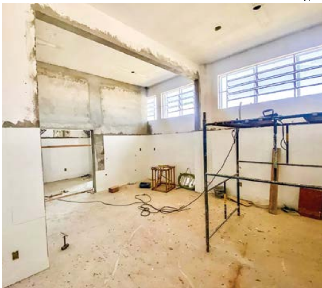
Obra da Cozinha Piloto de Cruzeiro entrou na fase de acabamento; espaço vai atender sete mil alunos
