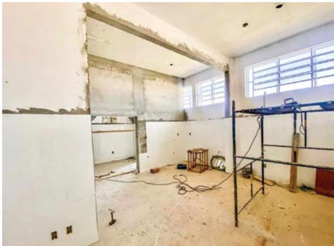
Obra da Cozinha Piloto de Cruzeiro entrou na fase de acabamento; espaço vai atender sete mil alunos
