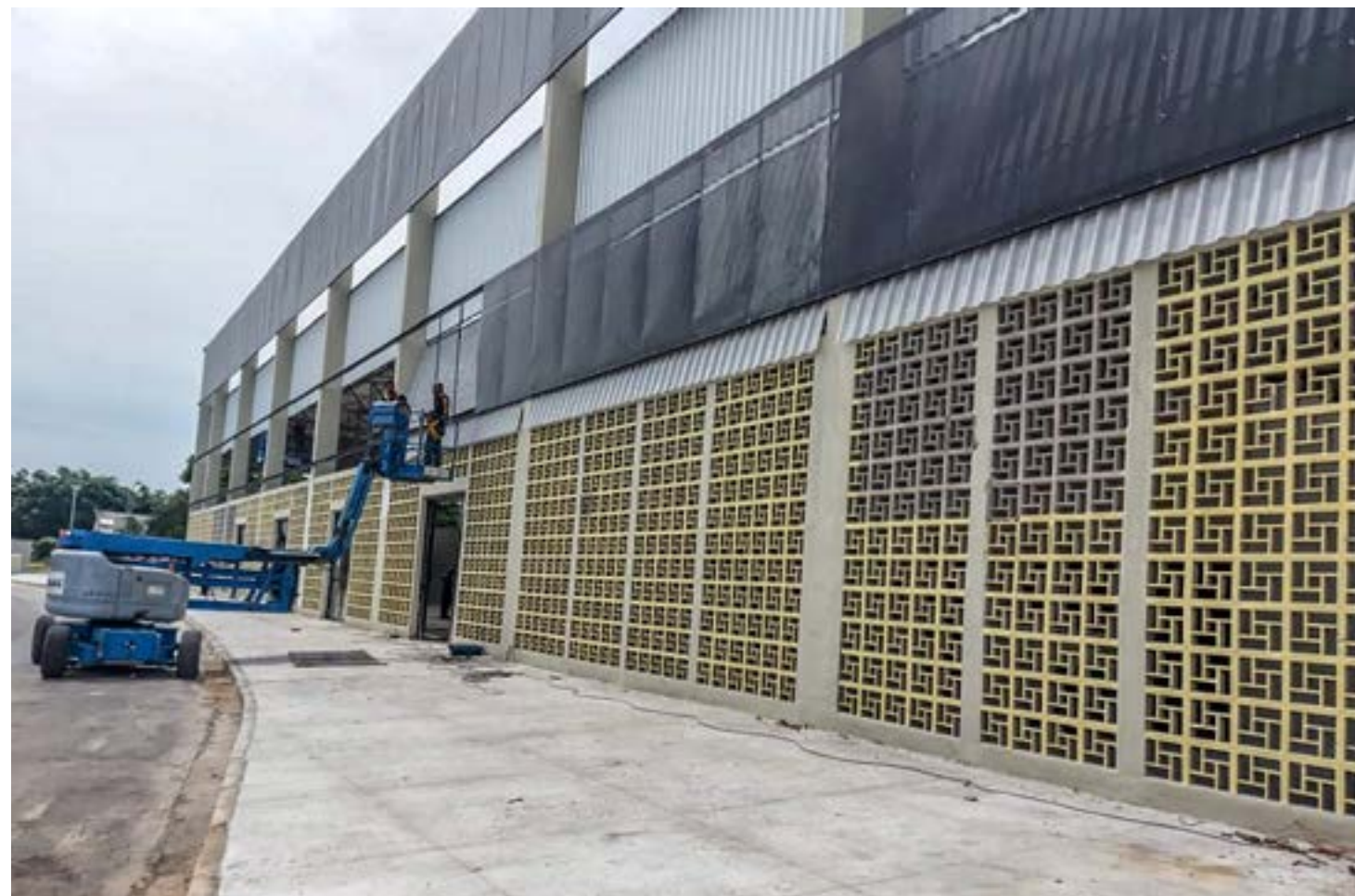
Obras do terminal rodoviário entregue em Moreira César; novos trabalhos projetam prédios como unidade próxima à rodovia Presidente Dutra
